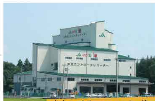
中央カントリーエレベーター竣工
