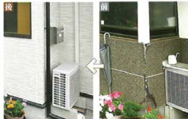
▲工事前、前回の内陸地震時は右のように被害が出ていましたが、工事した後に起こった東日本大震災では被害は出ませんでした
